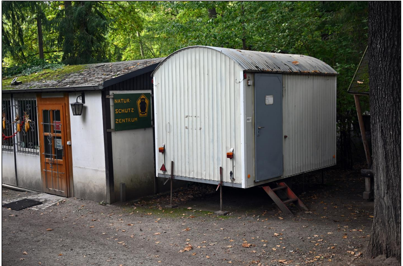
Abbildung 6: Schleuderraum im vorhandenen Bauwagen
